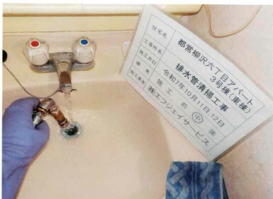
洗面所作業中
